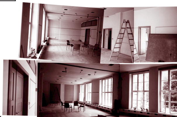
seminarraum während des umbaus
